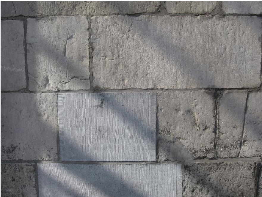
De oude blokken Naamse steen aan deze gevel zijn eerst met de hand vlak gemaakt en daarna pas gefrijnd. Recente vervangingen met lisse hardsteen (midden en middenonder) zijn vlak gezaagd en daarna gefrijnd. Het eindresultaat sluit niet goed aan bij de oorspronkelijke omgeving, omdat het de onvolkomenheden van het handwerk mist en het materiaal anders is. Een voorbeeld van 'Imiteren'.
