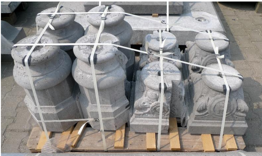
Gerestaureerde elementen van een hardstenen zuilengalerij staan klaar voor veilig en schadevrij transport naar het werk.
